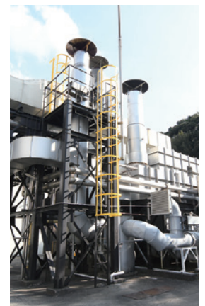
熱源・脱臭装置 燃料転換
