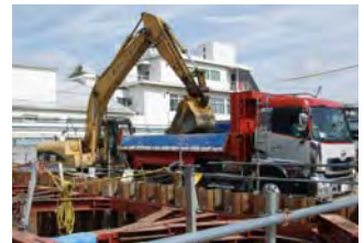
写真1 多摩川工場跡地における土壌汚染対策工事
