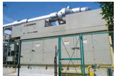
写真1 導入したコ・ジェネレーションシステム
