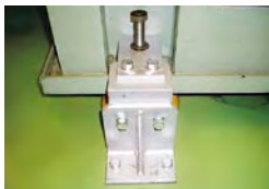
写真2 生産設備の固定
