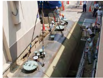
写真1 二重殻構造タンクへの更新
