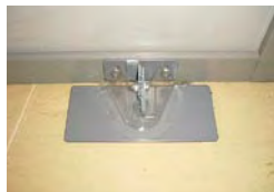
写真3 事務所設備の固定
