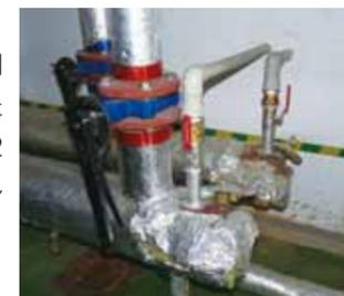
工場への温水配管に接続されたコンプレッサーからの熱回収
