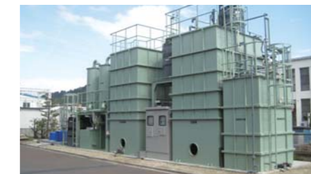
【写真2】地下水浄化施設
