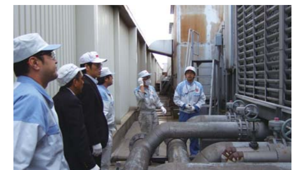
更新を検討するために既存の空調システムを確認
