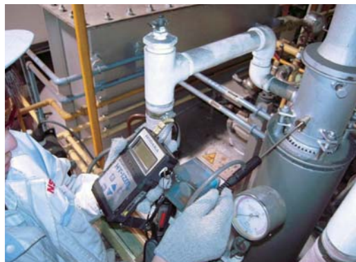
排ガスを測定し、燃焼状態を最適化
