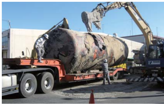
地中から掘り出したタンク
