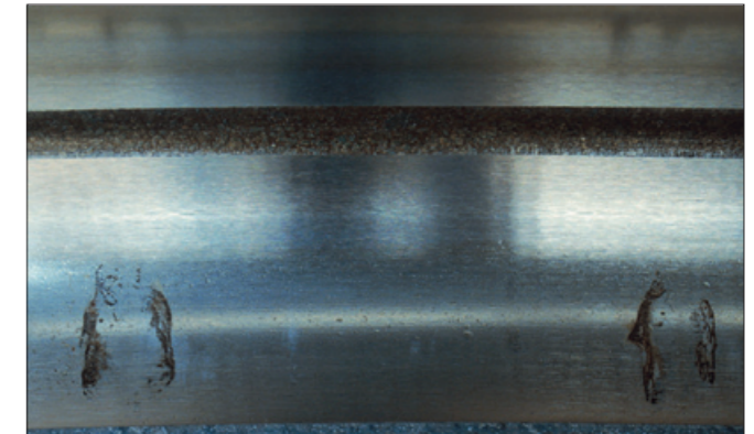
写真16-2 ●旋回輪軸受の外輪。 ●軌道面に生じたボールピッチのさび。 ●運転休止時の水分の凝結によるもの。
