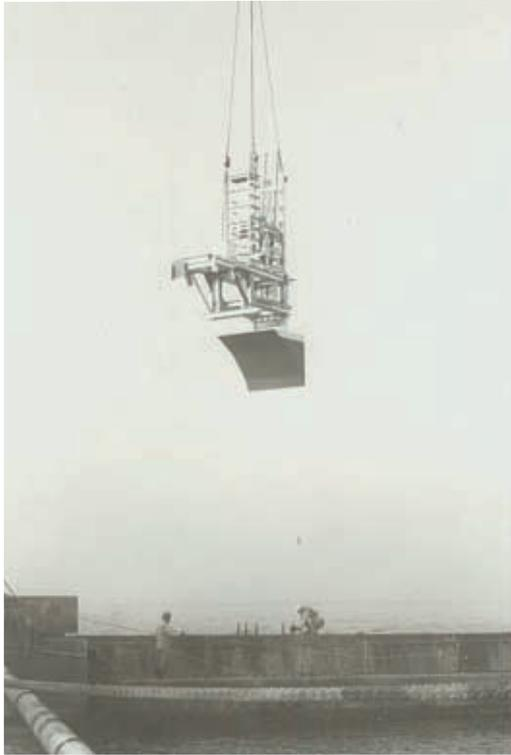
図3 G-1T 浮体（排水量1t）海上試験のための突堤据付
