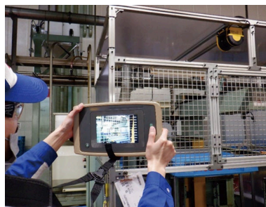
石部工場でのエアリー漏れ検出の様子
