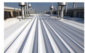
NSK埼玉工場屋根の断熱塗装
