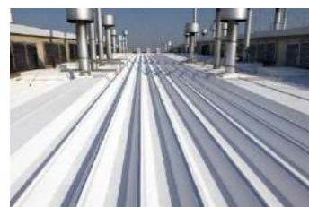
NSK埼玉工場屋根の断熱塗装
