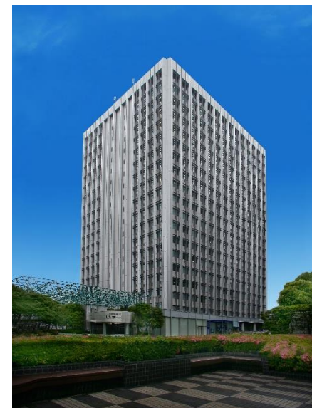
本社ビル (品川区大崎)
